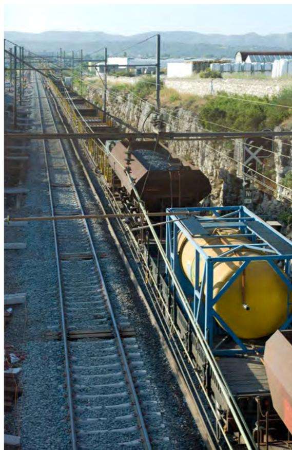
Véritable usine roulante, une suite rapide est composée d'une succession d'engins qui interviennent de façon simultanée pour renouveler l'ensemble des composants d'une voie ferrée : les rails, les traverses et le ballast. Cette technique permet de remettre à neuf près d'1 km de voie par jour contre 200 m si l'on utilise des moyens classiques.
